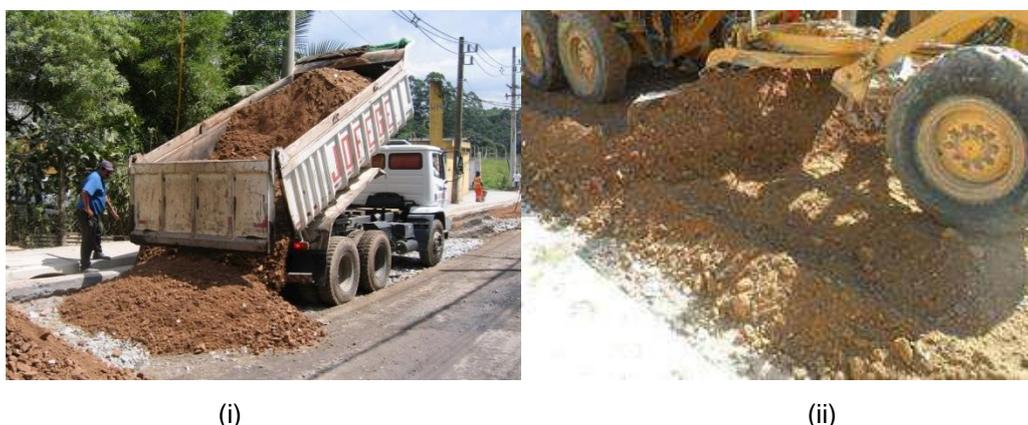
Figura 4.5 – (i) lançamento de RCD, e (ii) espalhamento com motoniveladora
