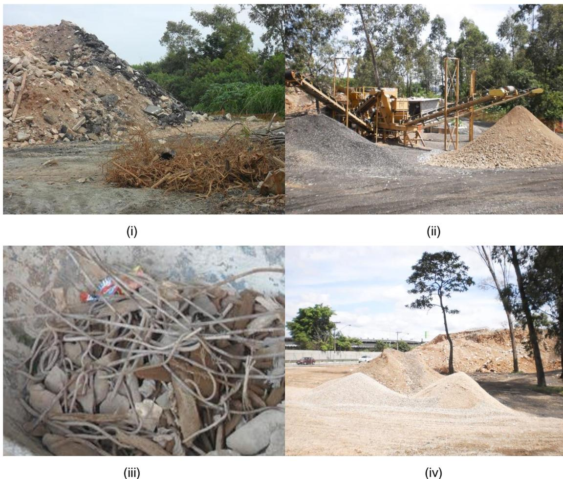
Figura 3.4 – (i) estocagem do RCD e retirada de materiais contaminantes, (ii) britagem do RCD, (iii) catação de contaminantes após britagem, e (iv) estocagem em pilha do agregado reciclado
