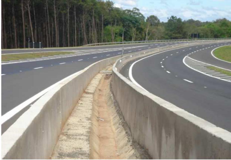
**Figura 3.29 - Drenagem – Autopista Maden Colon - Panamá – seção com barreira central**
