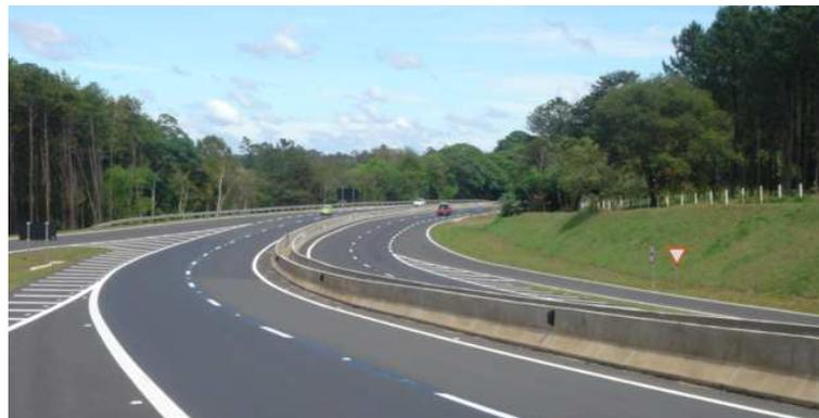
**Figura 2.10 - Dispositivo de Proteção Central Contínuo Rígido em Canteiro Central Estreito - Autopista Máden Colón (Panamá)**
