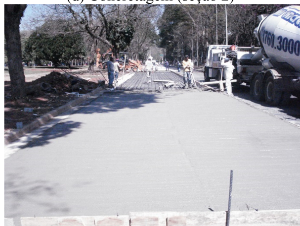
(f) Concretagem (seção 2)
