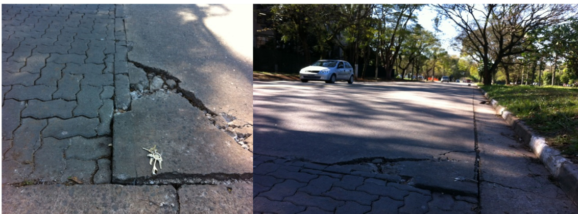
Figura 4. 15 - Defeito na junta da seção
