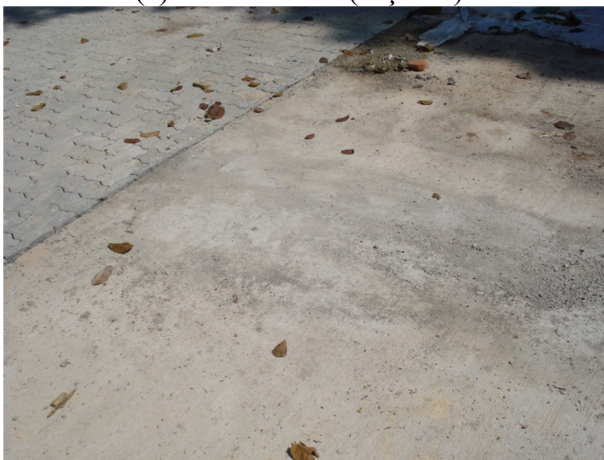
(c) Junta entre a pista e o pavimento intertravado (seção 1)
