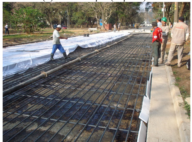
(d) Armadura longitudinal (seção 4) e cura (Seções 1 e 2)
