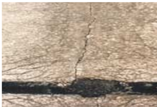
Figura 2. 28 - Fissuras "D" em uma fissura de PCCA (FHWA, 2013)
