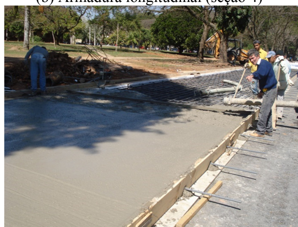
(d) Concretagem (seção 2)
