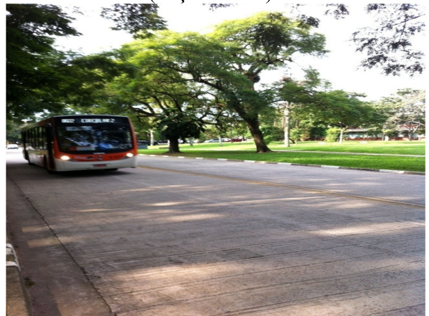
(f) Pista em operação (vista da seção 3)
